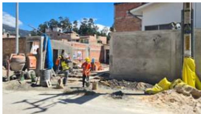
Foto N°01: Construcción del muro perimétrico y mejoramiento de caseta de vigilancia
