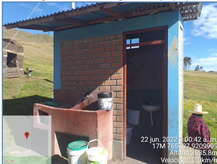
Fotografía III.3 - 14 Servicio Higiénico en Majadapampa
